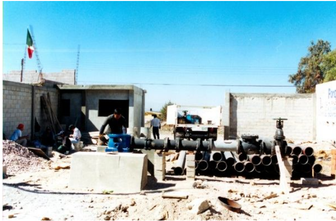
Figura No. 25 “Armado en campo de tren de descarga”
