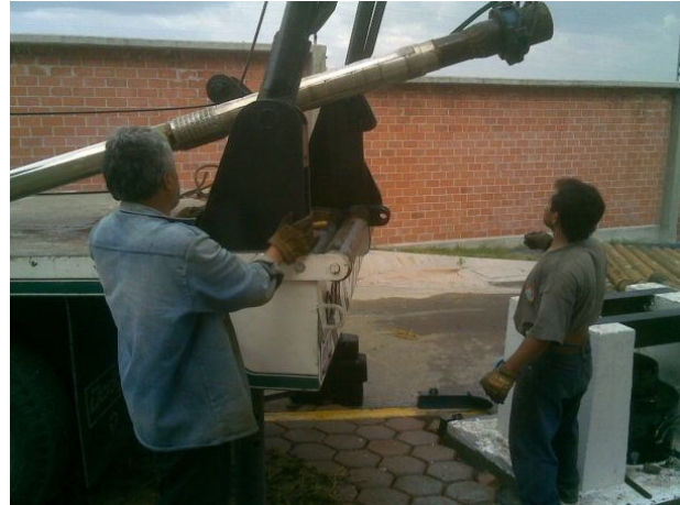
Figura No. 33 “Instalación de equipo de bombeo de repuesto”
