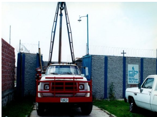
Figura No. 1 “Grúa No. 1 BECSA”
