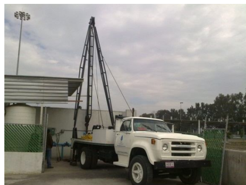
Figura. No. 2 “Grúa No. 2 BECSA”
