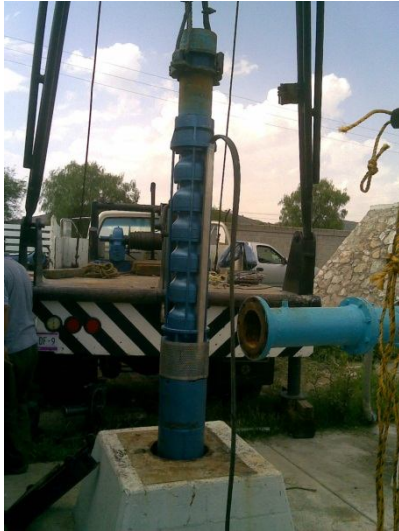
Figura No. 32 “Mantenimiento de Pozo (Maniobra de desinstalación e instalación de equipo de bombeo)”
