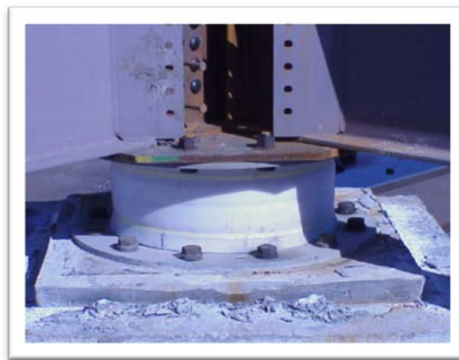
Figura 2.11 Imagen real de un apoyo elastomérico
