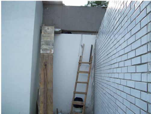
Vista de la cara interna de uno de los muros del habitáculo
