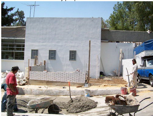
Preparativos para la colocación del piso
