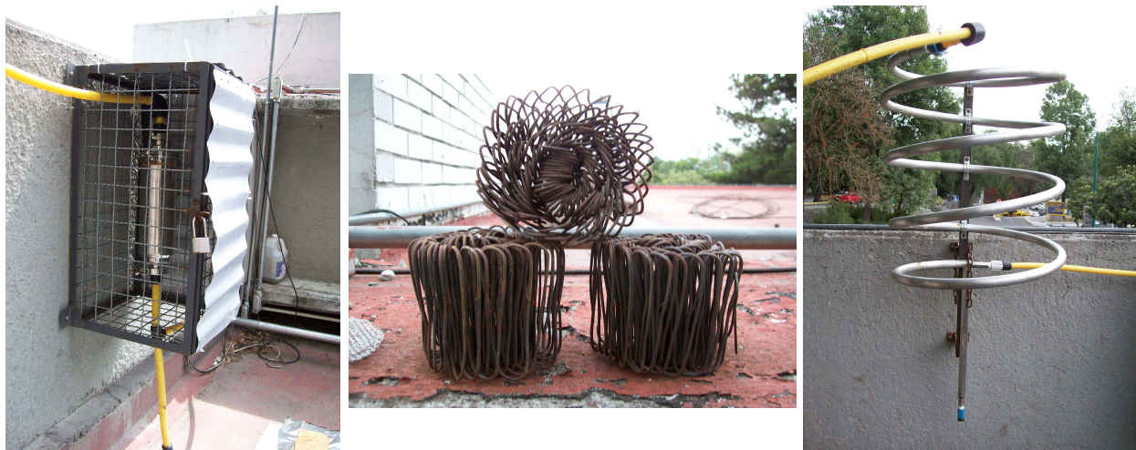
Figura V.8 – Componentes del sistema para el manejo del biogás (I). l zquierda, filtro para la remoción del H_2S ; centro , madejas de Fe_2O_3 del lecho del filtro; derecha , serpentín
