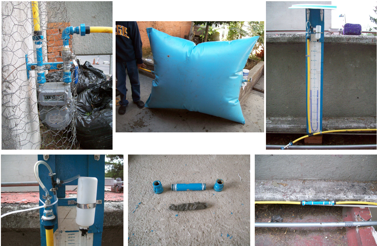
Figura V.9 – Componentes del sistema para el manejo del biogás (II). Arriba a la izquierda, flujómetro; arriba al centro, reservorio de biogás; arriba a la derecha, manómetro-válvula de alivio; abajo a la izquierda, punto de muestreo en el manómetro-válvula de alivio; abajo al centro, elementos de la trampa de llama; abajo a la derecha, trampa de llama instalada
