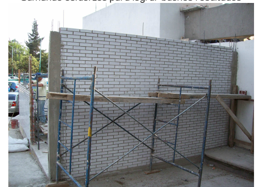
Muro norte listo para la colocación de cadena
