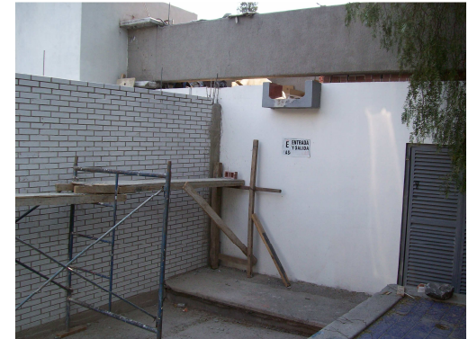
Finalización de uno de los muros del habitáculo
