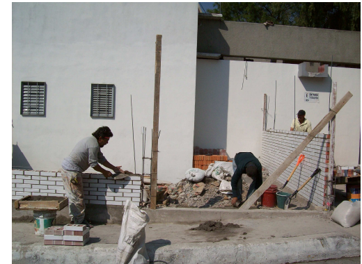
Inicio de los trabajos de levantamiento de muros
