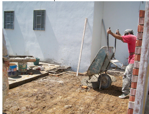
Vertido de mezcla para la conformación del piso
