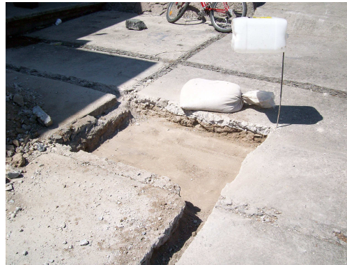
Inspección del subsuelo
