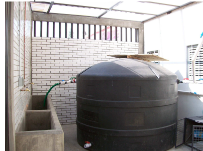
Vista completa del reactor anaerobio R-II
