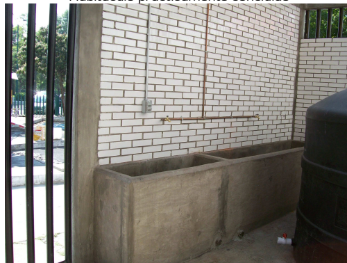
Aspecto final de los estanques de sedimentación
