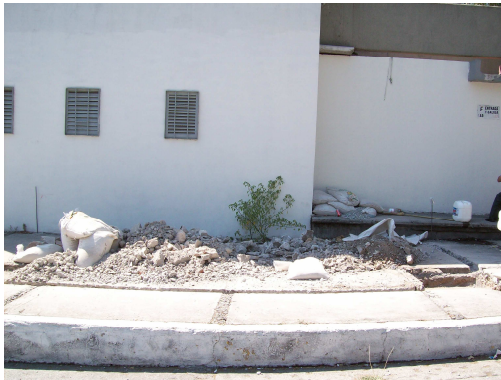
Delimitación y preparación del terreno
