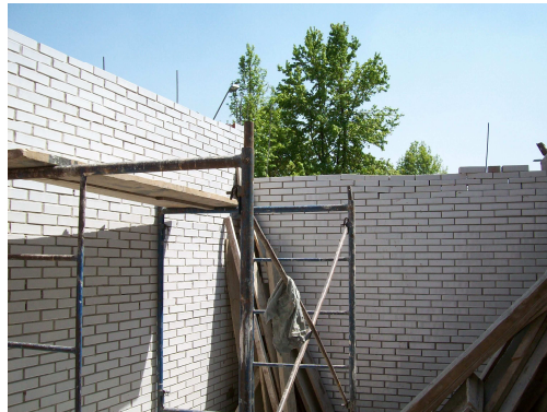
Armado de andamios para la culminación de muros
