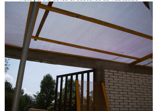
Instalación de reja-protección en la parte superior del habitáculo
