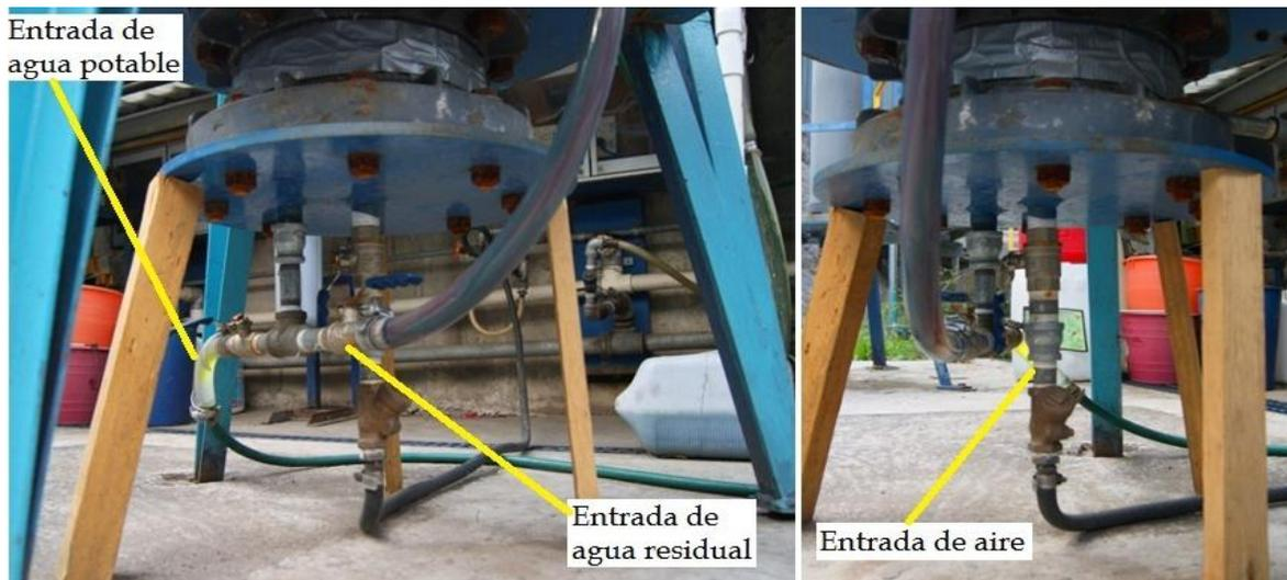
**Figura 3.8.** Detalle de la parte inferior de los filtros.
