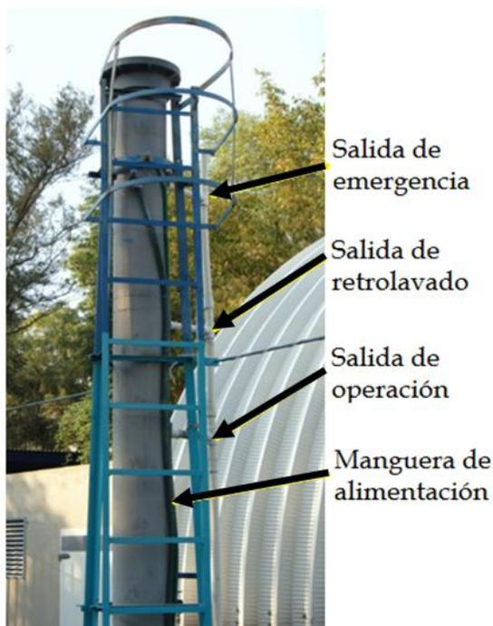
**Figura 3.6.** Vista de la parte superior de los filtros.
