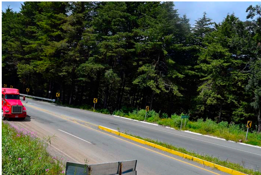
Figura 6.10 Señalamiento vertical en dirección Atotonilco-Pachuca.
