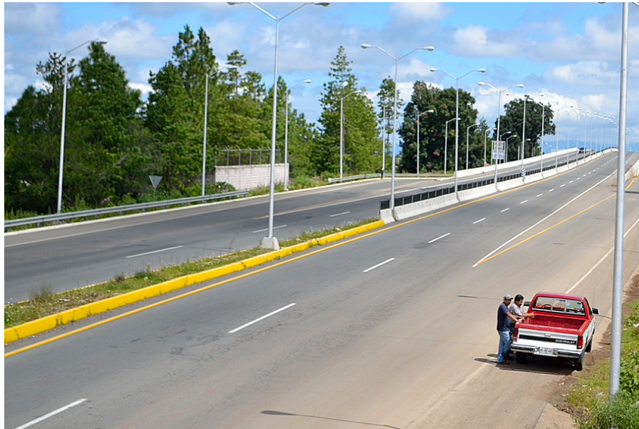
Figura 6.54 Paso superior vehicular en la carretera federal 105.
