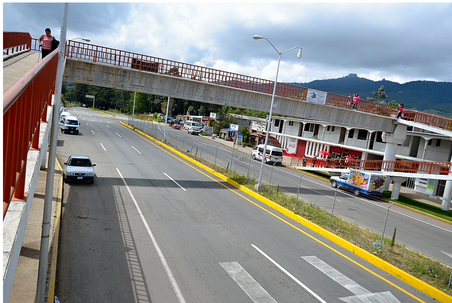
Figura 6.53 Puente peatonal en la carretera federal 105.
