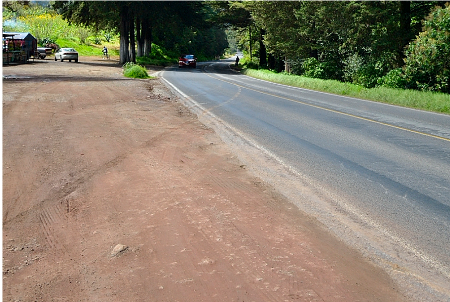
Figura 6.52 Derecho de vía que se pavimentará para la ampliación del camino (dirección Atotonilco-Pachuca).
