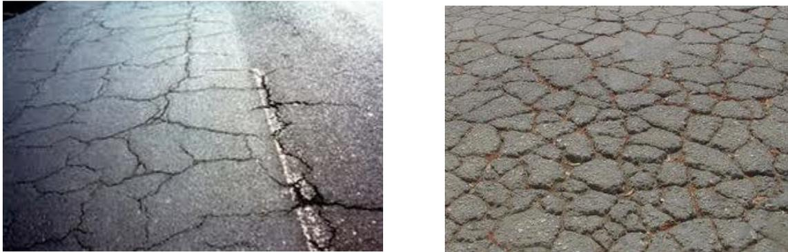
*Fig. 4 Patrón de piel de cocodrilo en carpeta asfáltica*
