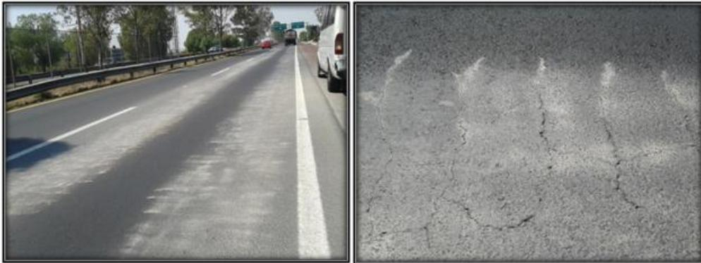
*Fig. 1 Presencia de fisuras en la autopista México- Pachuca. [7]*
