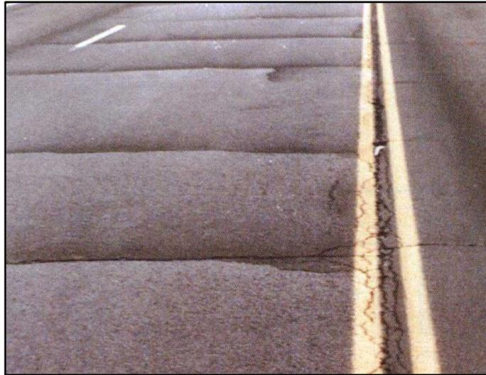
*Fig. 3 Pavimento que presenta alta gravedad de grietas reflejadas.*
