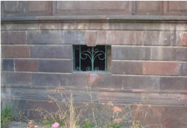
**Imagen 58. Aparejo con acabado almohadillado en muros de fachada.** Fuente: EGR. Año 2011.
