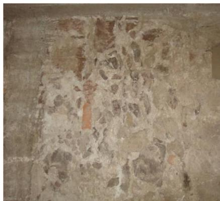
**Imagen 56. Muro de cimentación.** Fuente: EGR. Año 2011.
