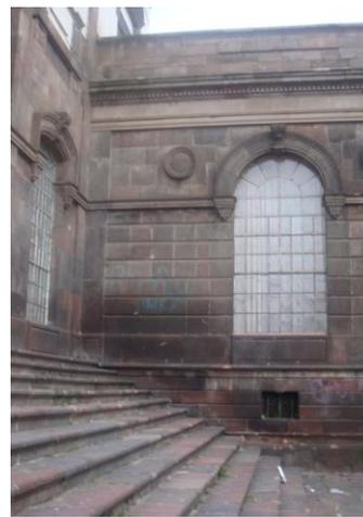
**Imagen 61 Escalera de acceso por la fachada posterior.** Fuente: EGR. El estado es regular, algunos escalones están rotos y las juntas tienen un mal acabado.
