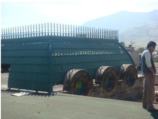
**Imagen 67.** Se ve la mansarda hecha de lámina troquelada.
