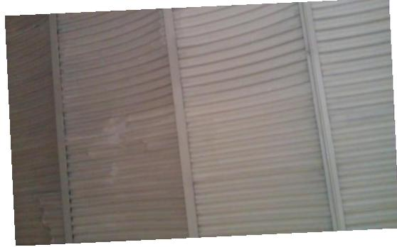
*Fotografías 40 y 41. Detalle de lámina acanalada en pasillos (izquierda) y en una de las aulas superiores (derecha).*
