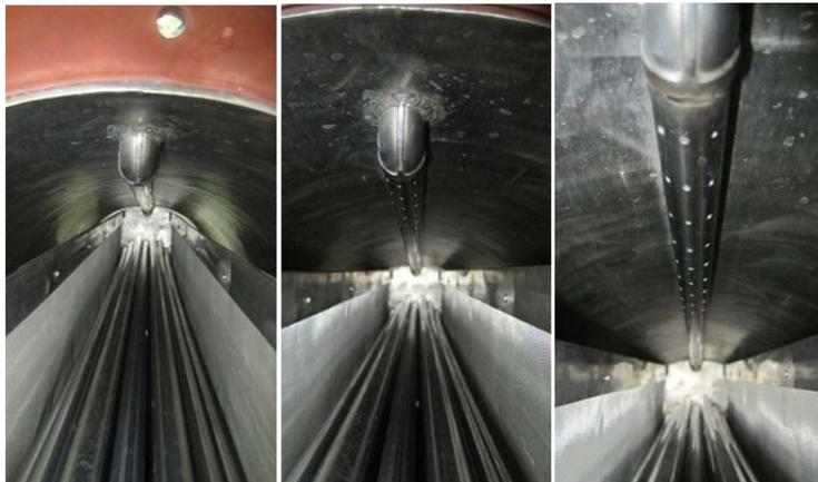
Figura 4.8 Distribuidor de agua de alimentación
