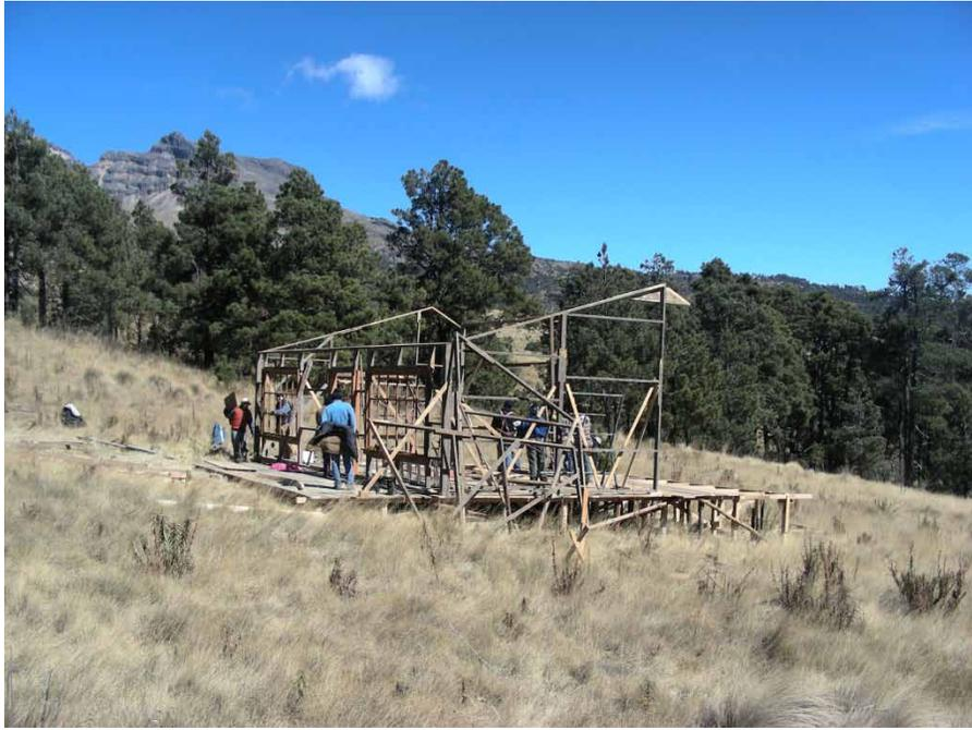
Con la base ya terminada se comienza el levantamiento de la estructura que soportara los paneles de madera.
