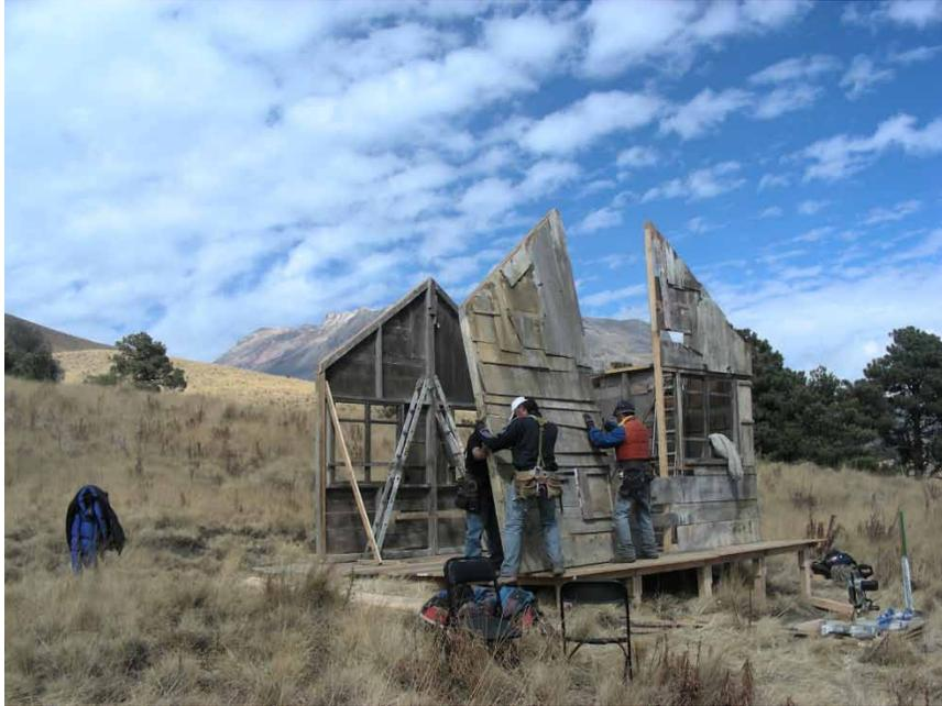
Al completar la estructura que forma el esqueleto se prosigue a colocar los paneles que formaran las paredes y techos de las cabañas.
