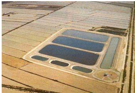
Imagen 11. Instalación de tratamiento mediante lagunaje natural. Imagen tomada del sitio Revista del Colegio de Ingenieros de Caminos, Canales y Puertos: http://hispagua.cedex.es/sites/default/files/hispagua_articulo/op/33/op33_3.htm (Fecha de actualización: 15 de enero del 2012)
