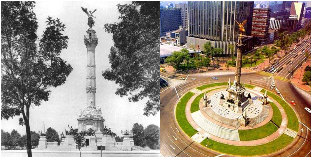
Imagen 3 Ángel de la Independencia. Se observa a la Izquierda una foto de 1910 y a la derecha una fotografía actual, Contrastando el nivel del suelo alrededor del Ángel de la Independencia. Imagen tomada del sitio México Maxico: http://www.mexicomaxico.org (Fecha de actualización: 6 de febrero del 2012)
