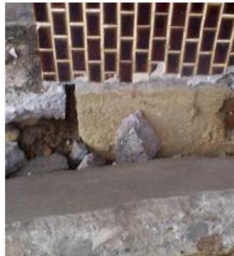
Figura 1.20c Asentamiento de una columna en la cimentación. (EEFIT, 2007)
