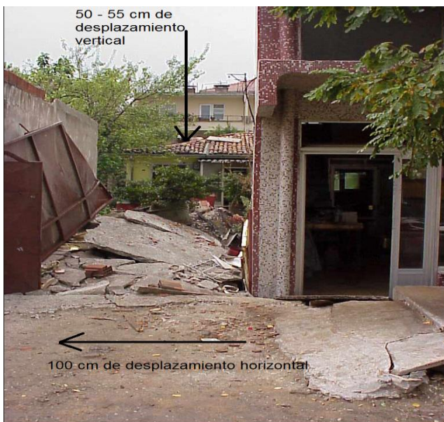
Figura 1.25. a) Edificio de dos niveles afectado por desplazamiento vertical y horizontal. (Sancio et al., 2004) 55 y b) Representación esquemática del tipo de modo de falla para un edificio con cimentación flexible afectado por el desplazamiento vertical y horizontal
