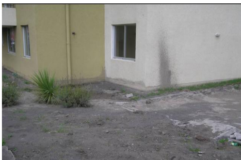
Figura 1.37. Edificio Riesco sufrió daños inducidos por licuación, la foto de la izquierda muestra la evidencia de sedimentos expulsados en la esquina noreste (S 36.79077°, W 73.08124°; 13:30 hrs 03/17/10). La foto de la derecha muestra daño en el interior del edificio debido al desplazamiento diferencial vertical. (GEER, 2010) 66
