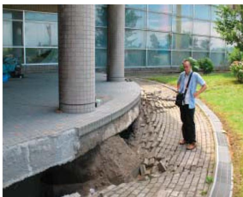
Figura 1.34. a) Edificio de tres niveles con \sim 5^\circ de inclinación con respecto a la vertical (Global Risk Miyamoto, 2007) 64 y b) Representación esquemática del tipo de modo de falla para un edificio con cimentación rígida
