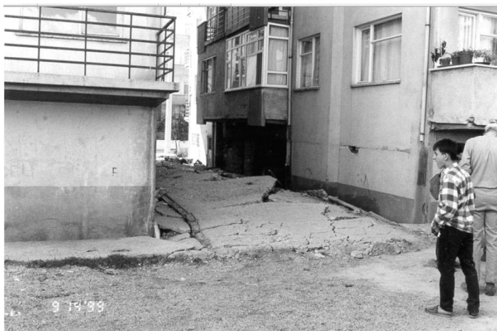
Figura 1.26. Edificio de concreto reforzado desplazado 57 cm hacia la calle (Bray et al. , 2000) 56
