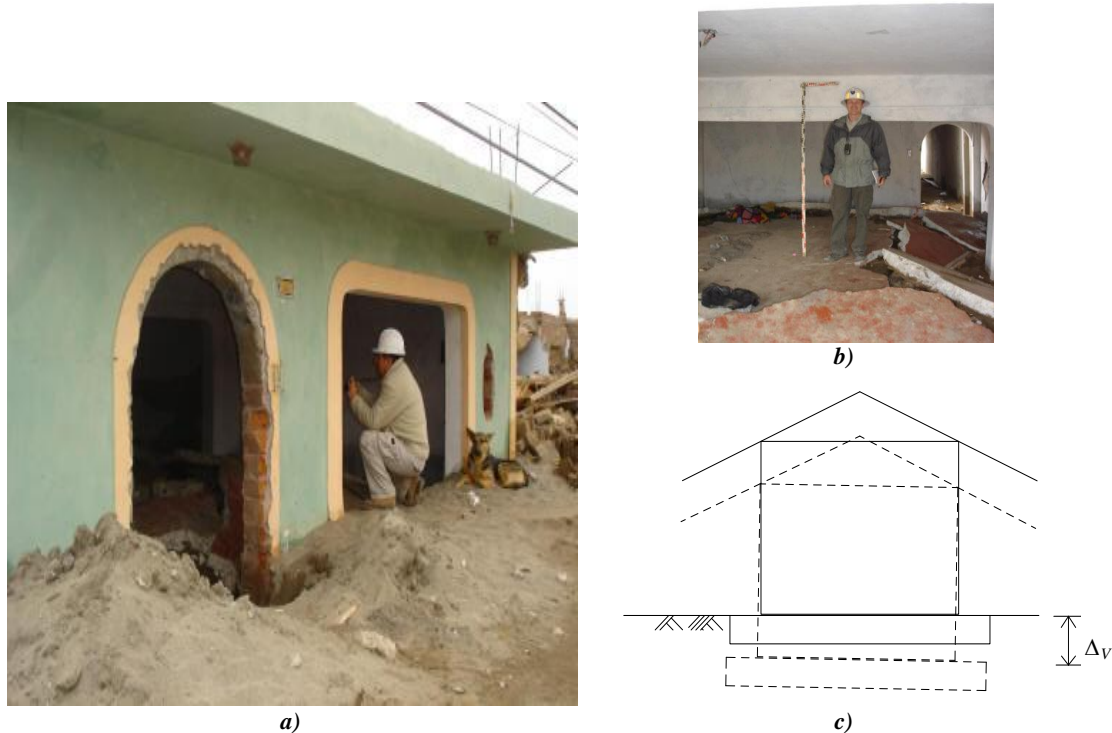
Figura 1.31. a) Residencia de un nivel afectada por un desplazamiento vertical de aproximadamente 0.7 m, b) Vista del interior de la residencia, se aprecia la gran cantidad de metros cúbicos de arena que ocupan el interior de la estructura (GEER, 2007) 61 y c) Representación esquemática del tipo de modo de falla para un edificio de un nivel con cimentación flexible
