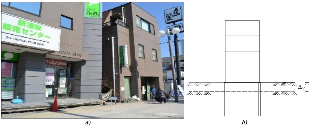
Figura 1.49. a) Desplazamiento vertical en relación con el edificio de la izquierda, el cual está cimentado sobre pilotes, ubicado en Urayasu (N35.6485, E139.9178) EERI (2011) 80 y b) Representación esquemática para el tipo de modo de falla de un edificio cimentado sobre pilotes y desplazamiento vertical del suelo circundante al edificio
