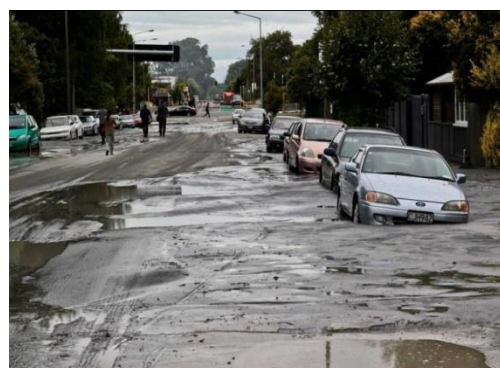
Figura 1.42. Inundación de calles por efectos del fenómeno de licuación (GEER, 2011)
