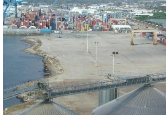
Figura 2.10. Vista aérea de la terminal de contenedores en el Puerto de Manzanillo, sobre el terreno en la parte frontal de la fotografía se observan las áreas de licuación (GEER, 2003)
