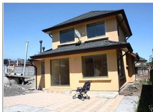
Figura 1.39. Desplazamiento diferencial vertical de 60 cm en una casa de dos niveles debido al fenómeno de licuación. (Mendoza et al. , 2011) 68
