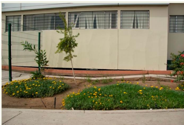
Figura 2.16. a) Daños parciales al piso debajo del muro en la cara norte del edificio D (GEER, 2010) 71 y b) Representación esquemática del desplazamiento vertical del suelo debido al fenómeno de licuación
