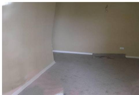
Figura 1.37. Edificio Riesco sufrió daños inducidos por licuación, la foto de la izquierda muestra la evidencia de sedimentos expulsados en la esquina noreste (S 36.79077°, W 73.08124°; 13:30 hrs 03/17/10). La foto de la derecha muestra daño en el interior del edificio debido al desplazamiento diferencial vertical. (GEER, 2010) 66
