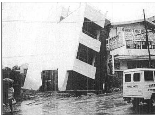
Figura 1.7. a) Edificio de tres niveles afectado por desplazamiento diferencial vertical e inclinación de \sim 12^\circ , causado por el fenómeno de licuación en la ciudad de Dagupan (EERI, 1990) 44 y b) Representación esquemática del modo de falla para un edificio con cimentación flexible, que presenta desplazamiento diferencial vertical e inclinación
