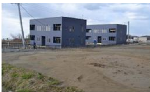
Figura 1.51. a) Desplazamiento vertical diferencial e inclinación de un edificio de dos niveles para uso residencial en la ciudad de Kamisu Japón (N35.917, E140.642) Ashford et al., (2011) 82 y b) Representación del tipo de modo de falla para un edificio con cimentación flexible que presente un desplazamiento diferencial vertical y una inclinación
