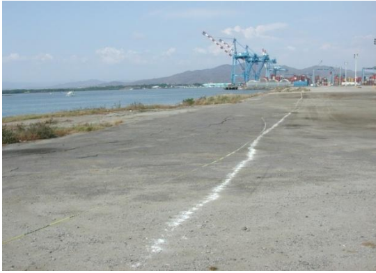
Figura 2.9. Desplazamiento lateral hacia el mar en el Puerto de Manzanillo (GEER, 2003)
