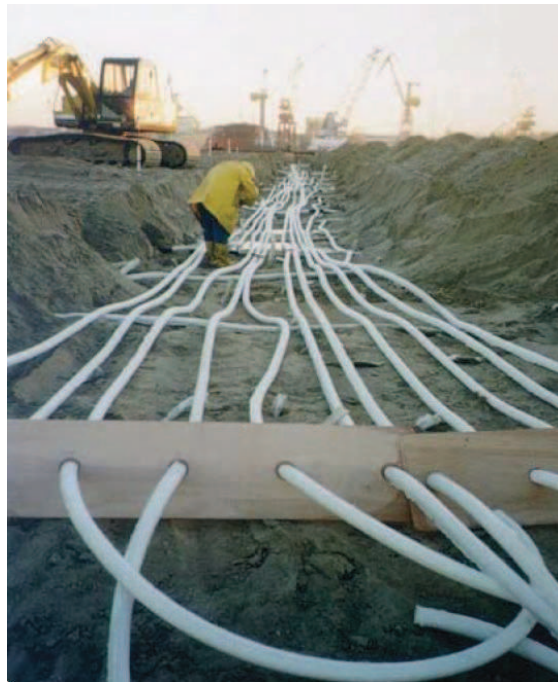
Figura 6.8.- Colocación de drenes horizontales (Menard, 2010)
