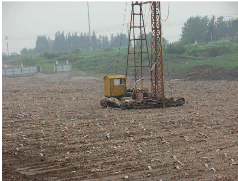
Figura 6.6.- Colocación de drenes verticales (Manh and Bao, 2009)
