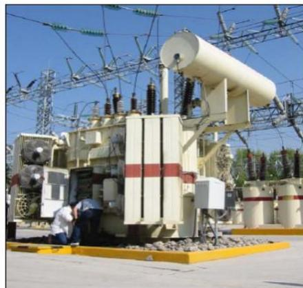
FIGURA 4-17 TRANSFORMADOR DE 30 MVA SUBESTACION PUEBLA 1
