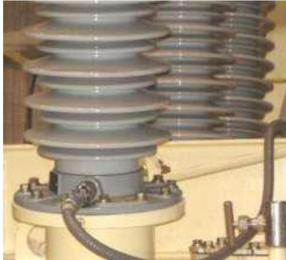
FIGURA 4-6 CONEXIONES PARA MONITOREO DE BUSHINGS
