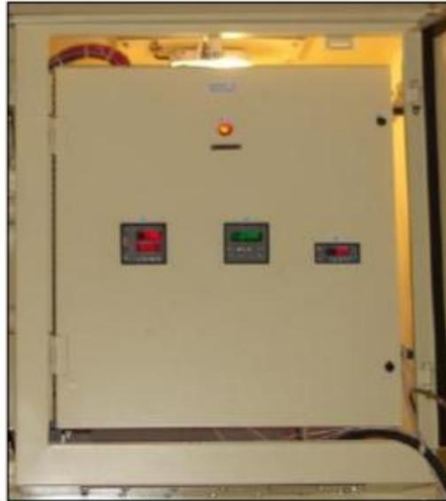
FIGURA 4-3 IED's UBICADOS EN EL GABINETE DE MONITOREO, MONITOR DE TEMPERATURA, DE BOQUILLAS Y DE HUMEDAD EN LA PARTE FRONTAL
