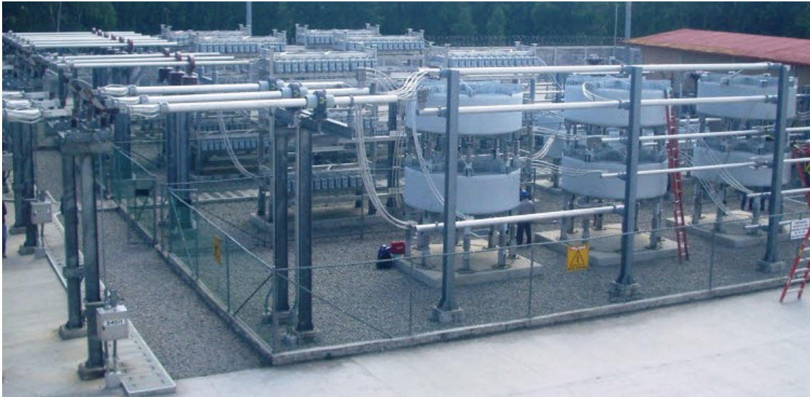
Figura A.3.: Compensador Estático de VAR's S.E. Nopala
