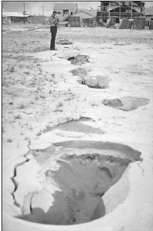
**Figura 2.9. Asentamientos causados por la licuación durante el sismo de Niigata, Japón 1964 (Steinbrugge, EERC, Universidad de California, Berkeley)**
