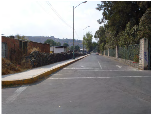
Esq. calle s/n. y Sinaloa Nte. viendo sobre calle s/n
