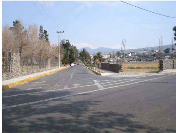
Esq. Tlaxcala Nte. y calle s/n. viendo sobre calle s/n
