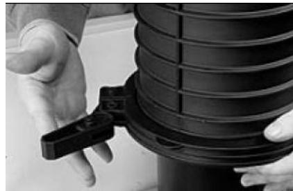
Figura 3.59. Colocación de las abrazaderas.
