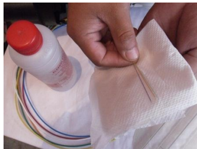
Figura 3.47. Limpieza de las fibras ópticas con isopropílico.
