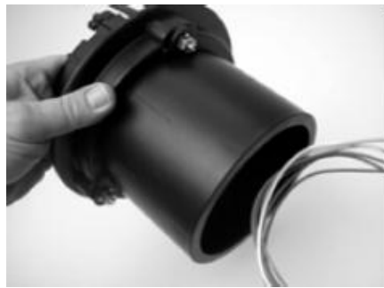
Figura 3.33. Colocación de los tubos Holgados en la base.
