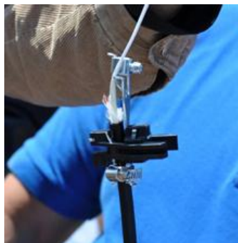
Figura 3.34. Fijación del cable de fibra óptica en el soporte.
