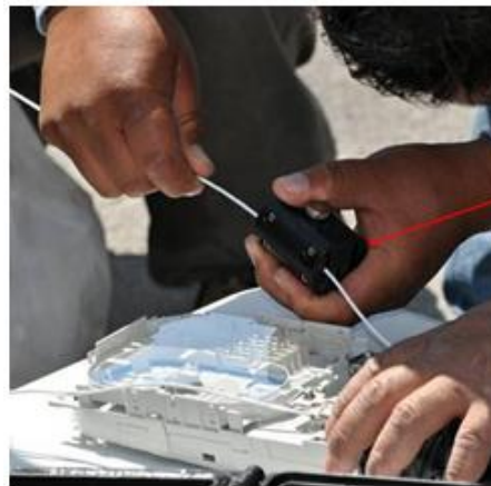
Figura 3.31. Trazado y limpieza del cable de fibra óptica.
