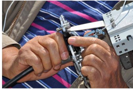
Figura 3.35. Armado de los elementos de sujeción.
