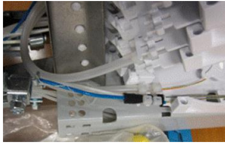
Figura 3.50. Fijación de los tubos de transporte en las charolas.
