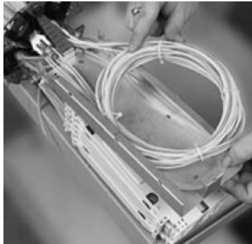
Figura 3.41. Colocación de cinturones en las fibras ópticas.
