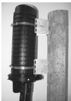
Figura 3.61. Fijación de cierre 450 BS en el poste.
