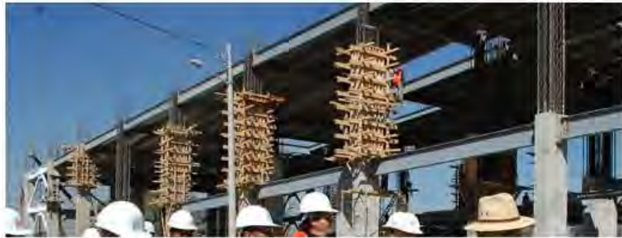
Columnas de concreto armado
