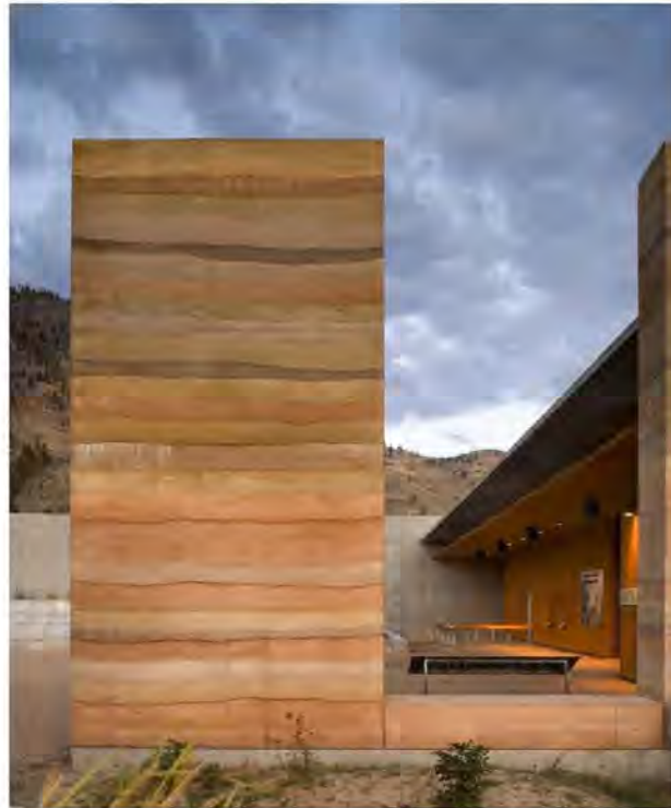
Vista al anfiteatro, muro de tierra.
