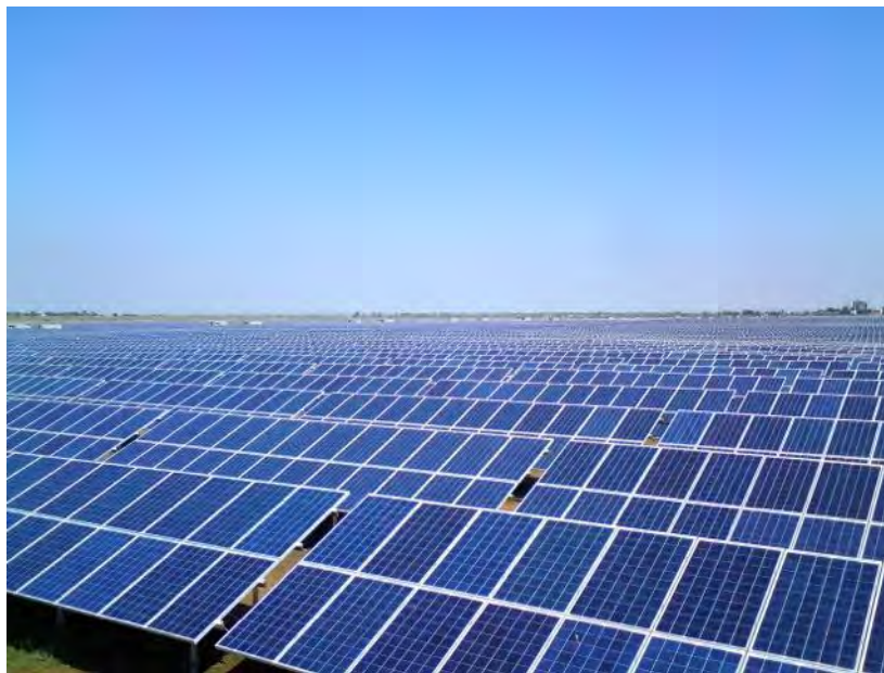
Figura 20 Parque Solar Okhotnykovo en Ucrania, de 80 MW fotovoltaicos 43
