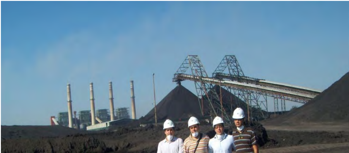
Figura 30 Vista de la central Río Escondido. Se observan las bandas transportadoras, chimeneas y calderas. 54
