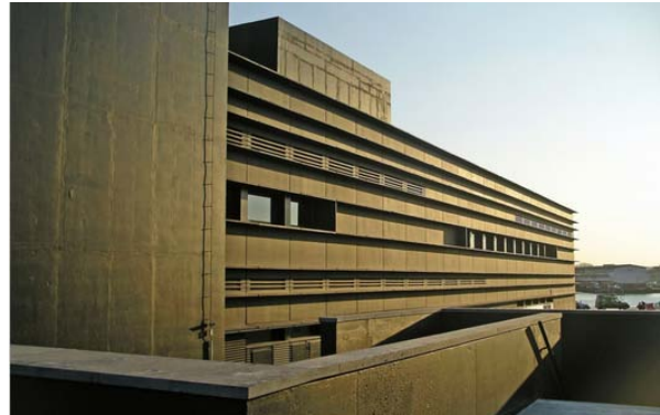
Vista lateral del Centro Comercial "A laxe"
