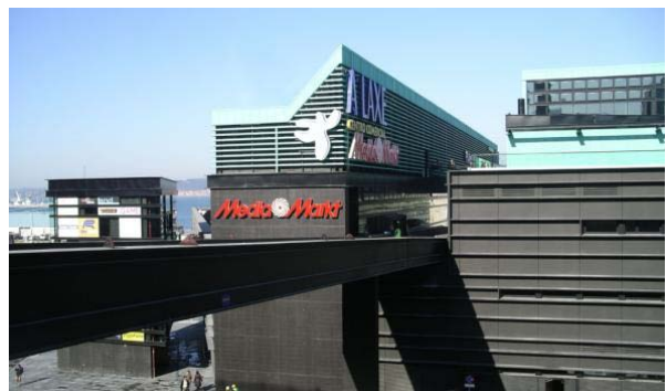
Vista al Centro Comercial “A laxe” desde el puente
