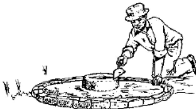
Deje la losa terminada curarse por lo menos 3 días, manteniéndola húmeda todo el tiempo. Después de que haya secado por más o menos 7 días, ponga 4 bloques de madera, de 1 ó 2 pulgadas de alto, debajo de los 4 lados de la losa para levantarla del piso. ¡Ahora, baile sobre ella! Una losa bien hecha no se romperá, aún con varias personas bailando sobre ella. Ponga una capa de mortero sobre el borde del forro del pozo y con cuidado ponga la cubierta en su
