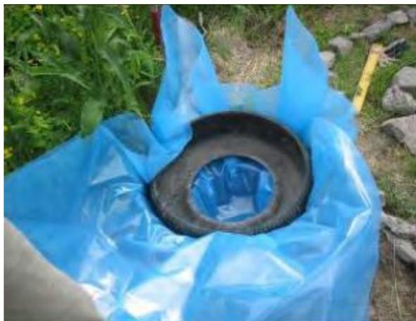
Una vez instalado el plástico, se pone el neumático dentro del hoyo y se procede a cortar el plástico sobrante teniendo la precaución de dejar unos 20 cms. en el borde para que el agua no rebalse. Una vez realizado esta parte debemos doblar el plástico hacia el interior del neumático y proceder a construir el borde exterior que puede hacerse con ladrillos o bien con piedras grandes y lisas.
