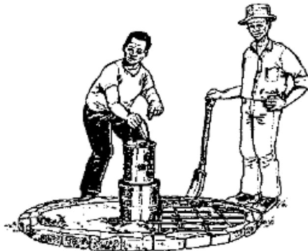
Quite el enrejado de varilla y haga una mezcla de concreto con 3 partes de grava, 2 partes de arena de río y 1 parte de cemento. Si no hay grava disponible, use 4 partes de arena y 1 parte de cemento. Vierta el concreto dentro del molde hasta llenar la mitad. Ponga el enrejado de varilla encima del concreto mojado. Agregue el concreto restante y nivele la losa con una madera.
