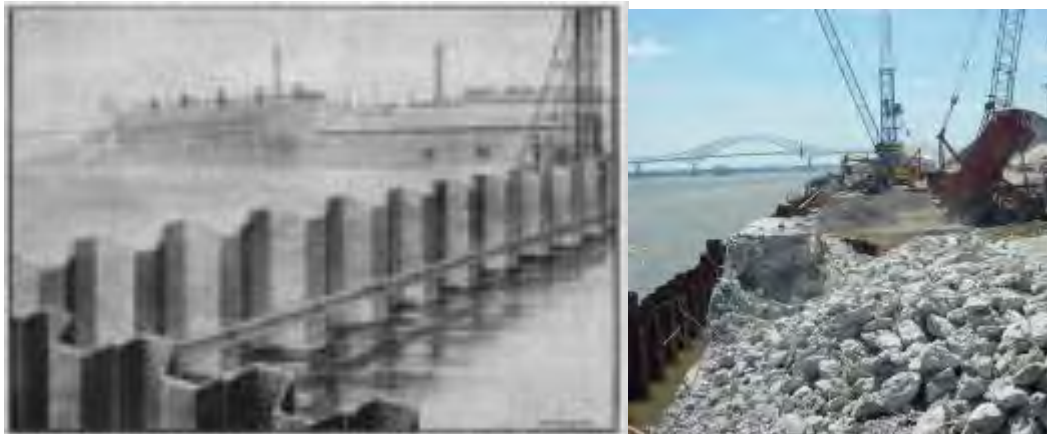
FIGURA: 26.- MURO MUELLE.
