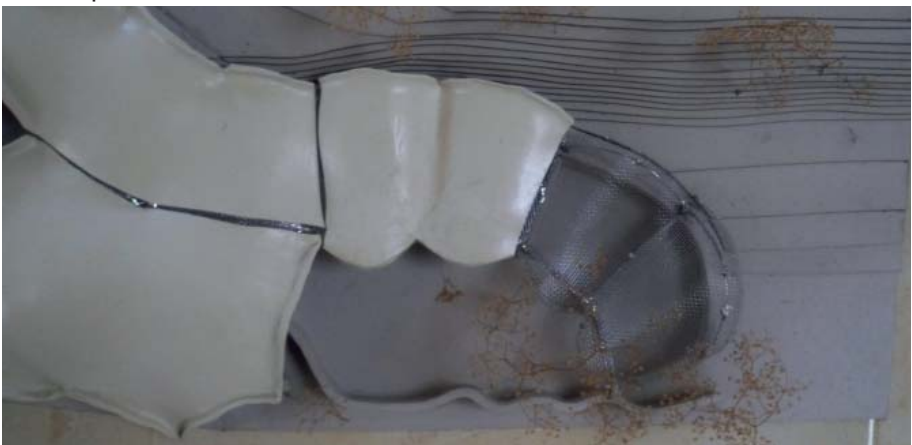
Vista superior de cubierta.
