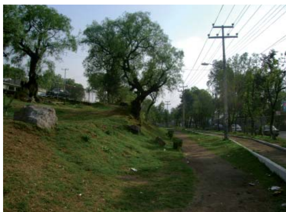
Fotografía del Relingo en época de lluvia.
