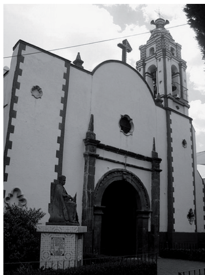
Im. No. 6: Fachada de la Iglesia Santa Cruz Acalpixca.
