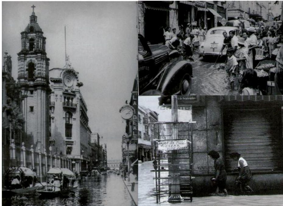
Figura 12. Inundaciones de la ciudad de México en 1925,1945 y 1951.
