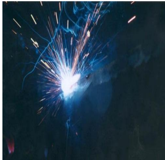
Fig. 3.1 Realización de cordón de soldadura.
