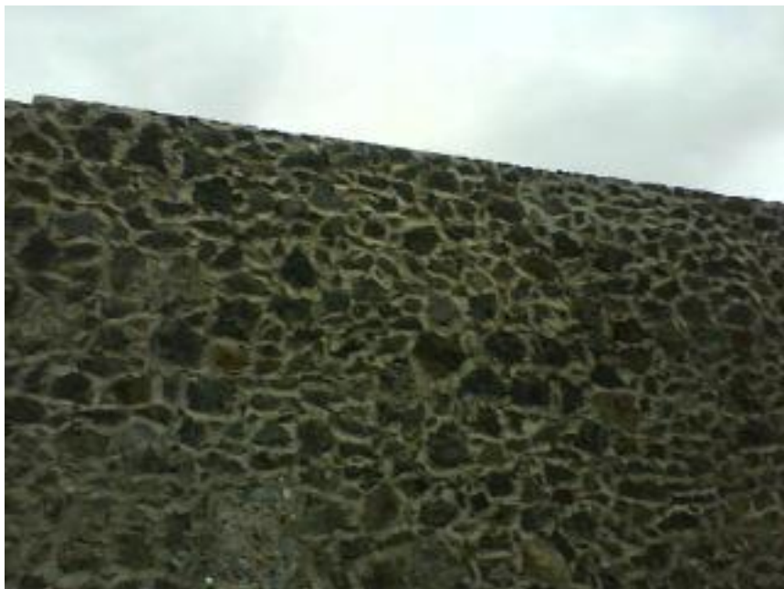
Fig. 35 Muro perimetral a base de piedra braza
