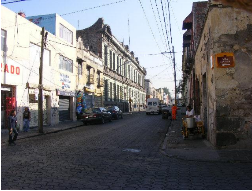
Fig. 26 (5) Vista de la Av. 5 de Mayo desde la calle 18 poniente.
