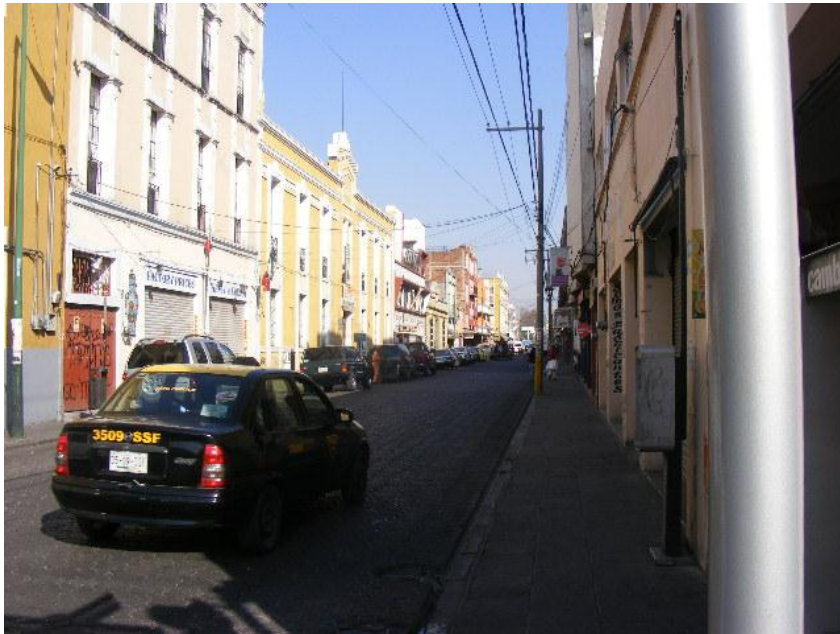
Fig. 24 (3) Vista de la Av. 5 de Mayo, entre calle 16 poniente y 18 poniente.
