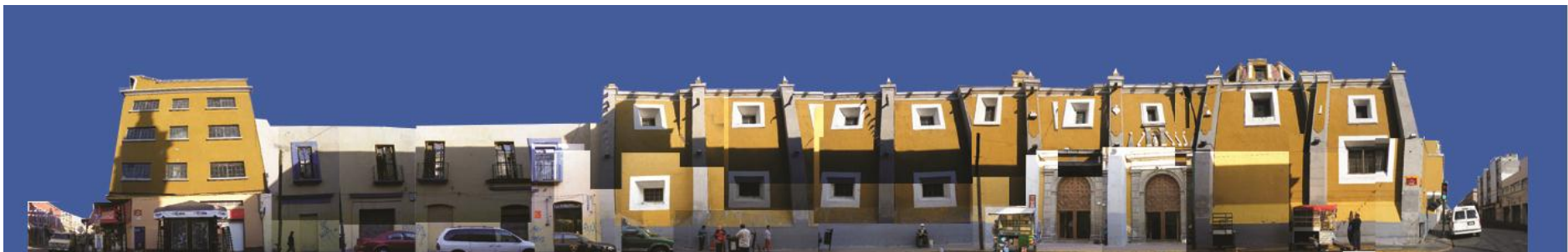
LOTE EN ESTUDIO, LARGUILLO 5 DE MAYO, ENTRE CALLE 16 PONIENTE Y 18 PONIENTE. FACHADA PONIENTE
