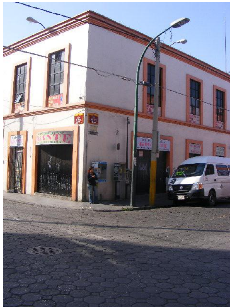
Fig. 23 (2) Vista a esquina sur oriente de la calle 16 poniente y Av. 5 de Mayo.
