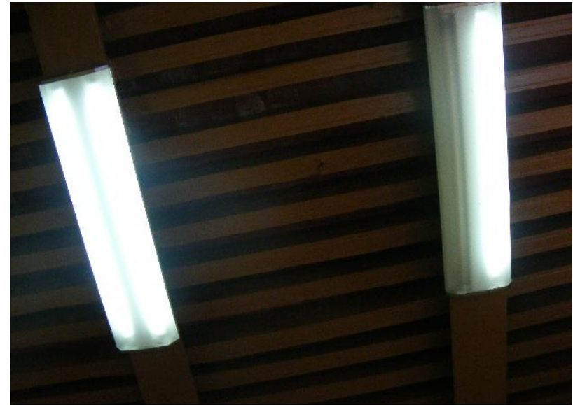
Fig. 15 Entrepiso de Vigueta y bovedilla, este se encuentra en el interior de la tienda, se presume que este haya sido el entrepiso que existía en los departamentos y el monasterio.
