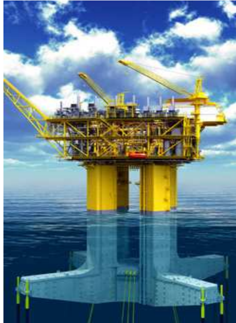
Fig. 4.3.3 Plataforma de piernas tensionadas (TLP)
