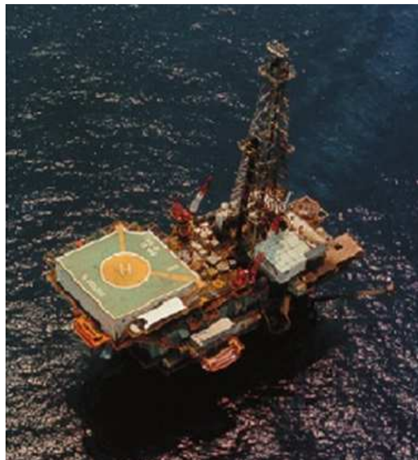
Fig. 4.2 Plataforma fija de perforación.
