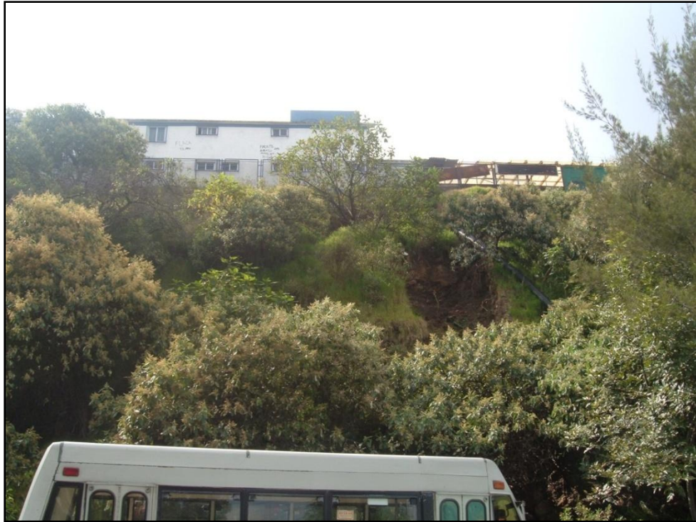
Deslizamiento ocurrido en la delegación Álvaro Obregón.
