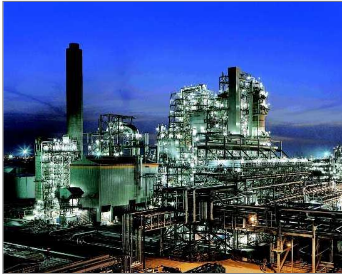
Figura 1.6. Planta petroquímica y de gas. PEMEX refinación.
