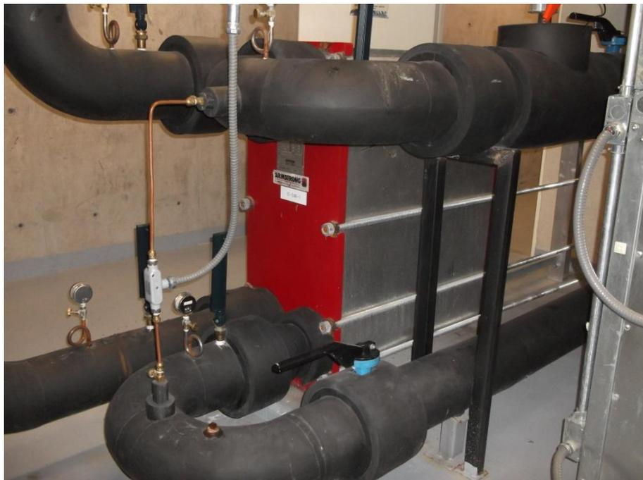
Figura 5.8 Tubería del intercambiador de calor
