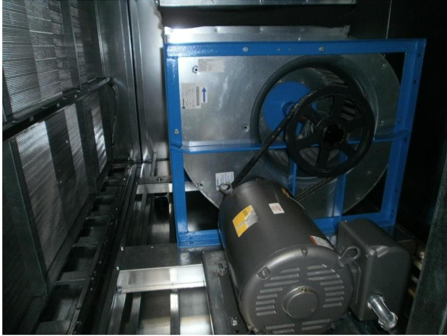
Figura 6.3 Motor y ventilador de una unidad manejadora de aire
