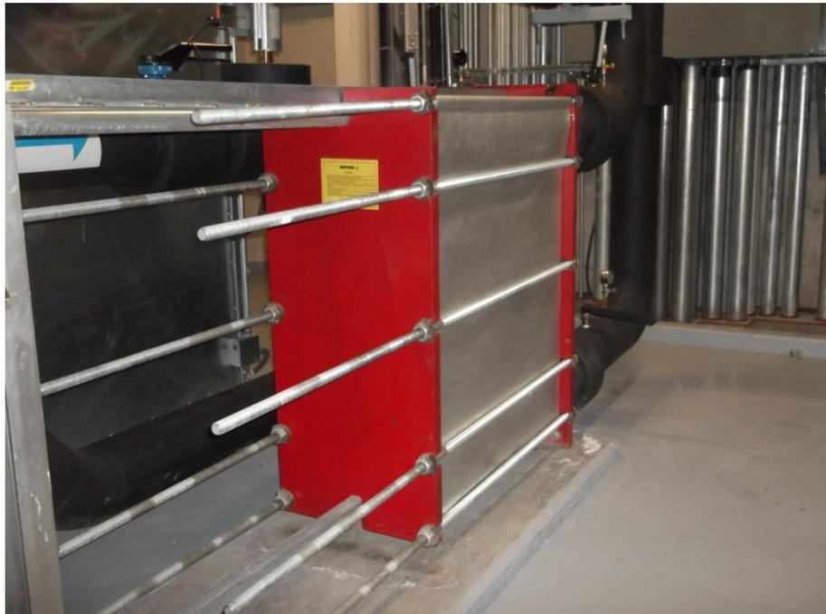
Figura 5.1 Intercambiador de calor de tipo placa y bastidor
