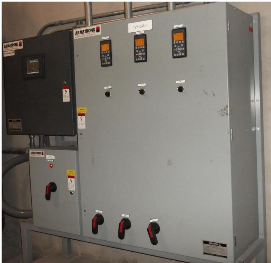
Figura 4.22 El controlador de velocidad variable IPS 5000
