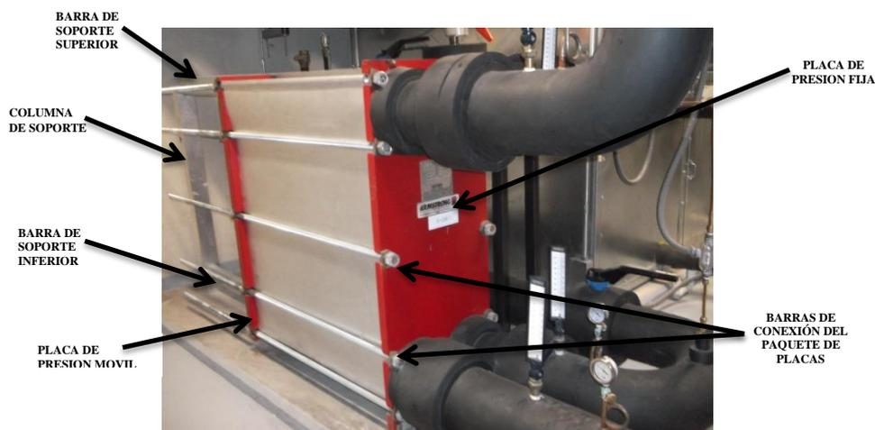
Figura 5.2 Descripción de las partes del intercambiador de calor
