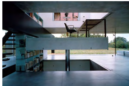
30) Elevador hidráulico en el interior
