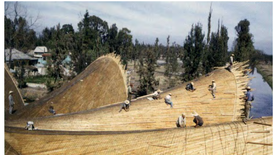
Im. 51 Vista del cimbrado para la cubierta desde la superficie de ésta. Fuente: Archivo Juan Guzmán, fotógrafo alemán cuyo nombre originario fue Hans Gutmann Guster
