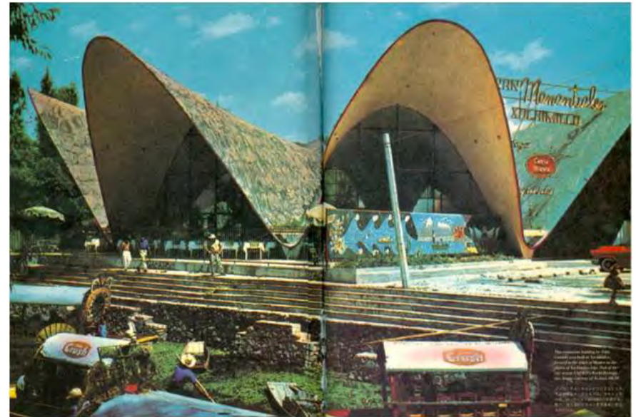
Im. 57. Fotografía Mural 1 (ubicación original) A + U Architecture and Urbanism: Architecture in Mexico. Marzo, 2002
