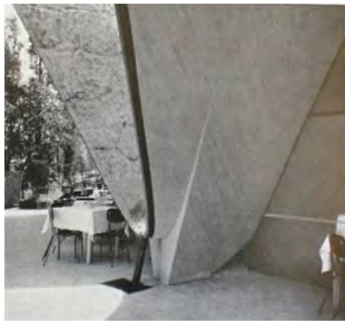
Im. 46 Apoyo remetido del paño del manto Revista Bauen + Wohnen, 1961
