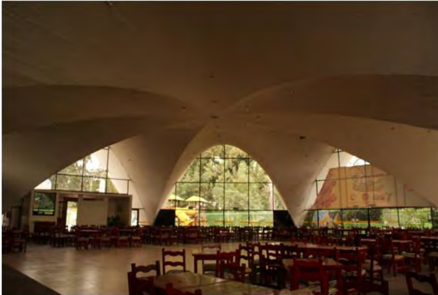
Im. 55 Vista desde el interior del edificio. Transparencia y ligereza. Fotografía de María Fernanda Gardea, mayo 2010
