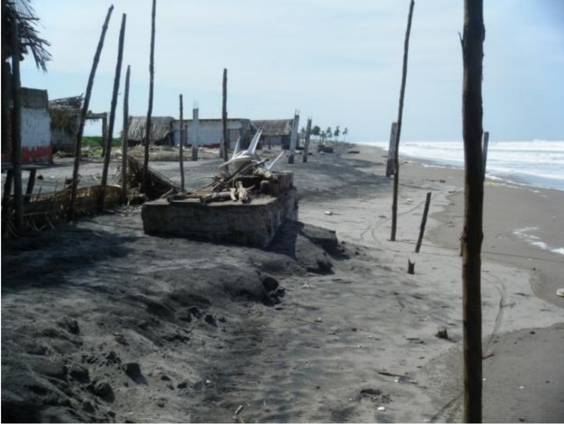
Figura 5.4 Pozos artesianos en la línea de marea alta de la playa El Colorado, 15 km aproximadamente al sur de Santa Cruz. Los pobladores de San Andrés refieren que los pozos son parte de las construcciones dañadas por la llegada de los huracanes Kenna y Rosa a la región, estos pozos se localizaban medio kilómetro hacia el mar respecto a su posición actual
