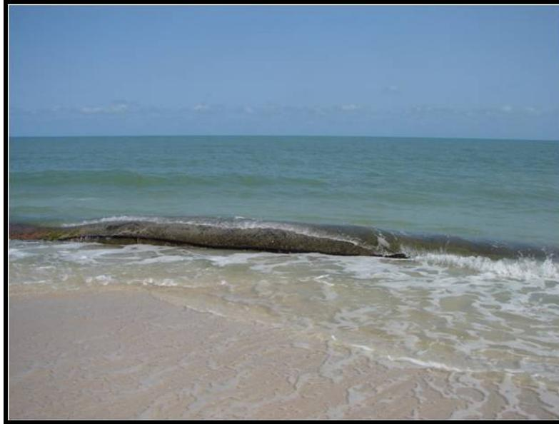
Figura 1-5 Muestra de geotextil instalado en la zona de estudio para contribuir a la acumulación de sedimentos
