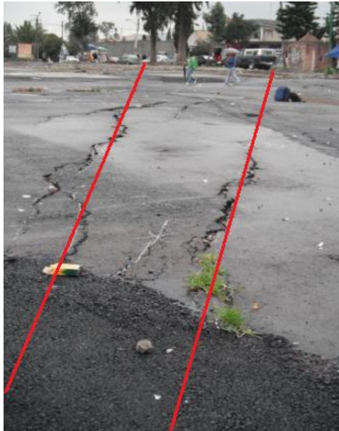
Figura 4.20 Fotografía del sistema paralelo de fracturas visible en la explanada del pueblo de San Juan Ixtayopan.
