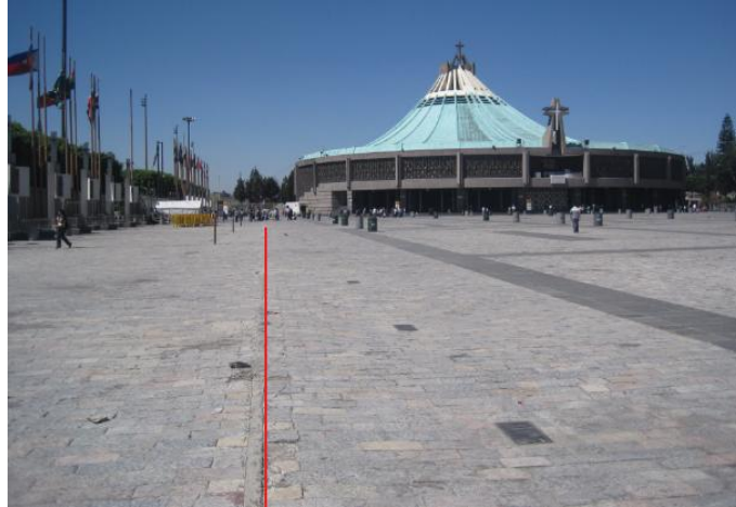
Figura 4.1 Fotografía de la explanada de la Basílica de Guadalupe que está afectada por fallamiento y fracturamiento.
