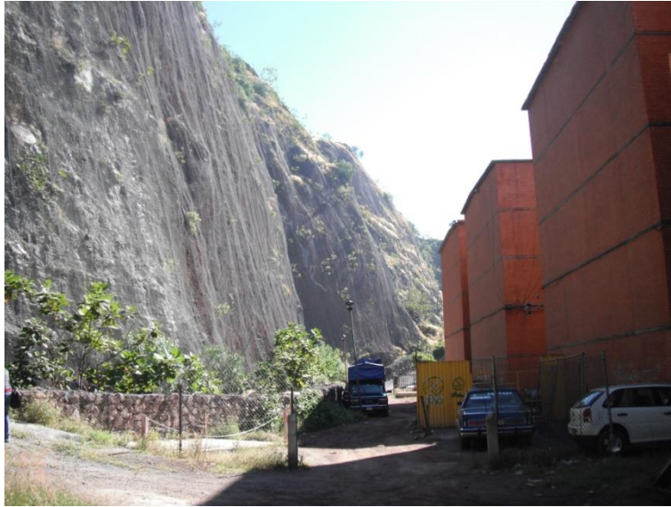
Figura 3.28 Fotografía que muestra las mallas para la contención de derrumbes.
