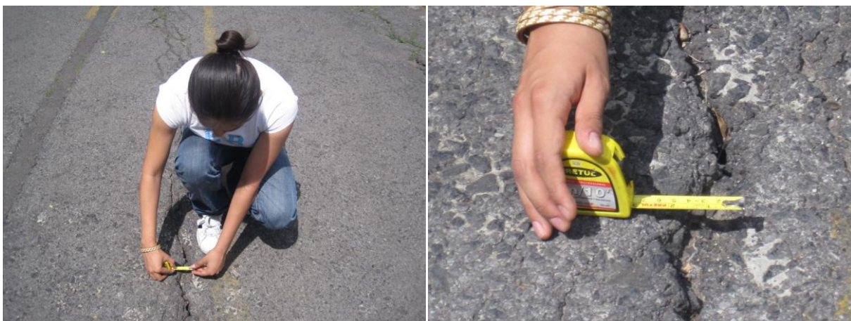
Figura 1.7 Medición de la abertura de una fractura.
