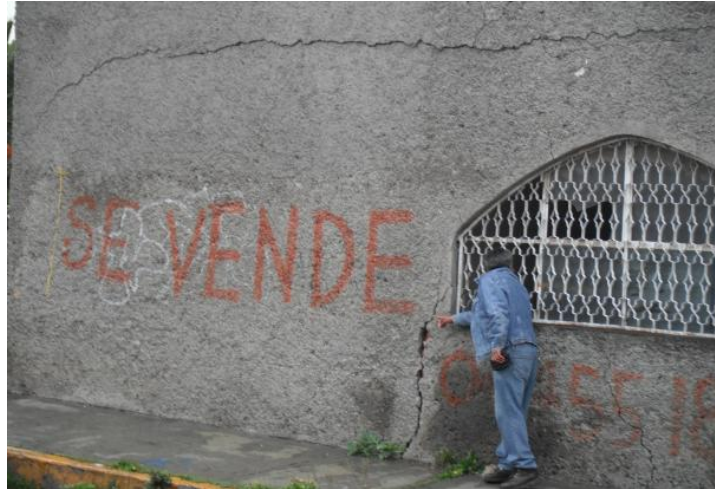
Figura 4.22 Fotografía de una vivienda abandonada.
