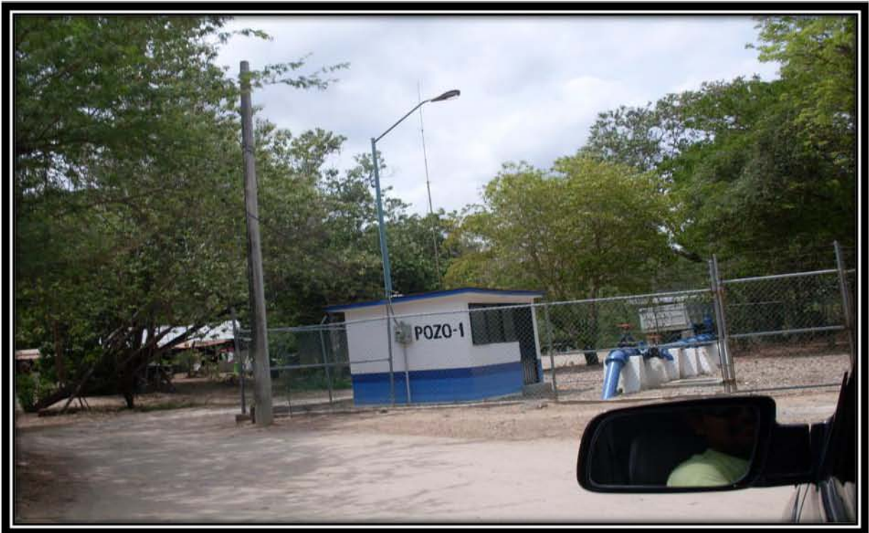
Pozo numero 1, de ocho existentes, que abastecen agua del río copalita al centro urbano-turístico, Bahías de Huatulco, Santa María Huatulco, Oaxaca (Edgar Talledos Sánchez, 2010)
