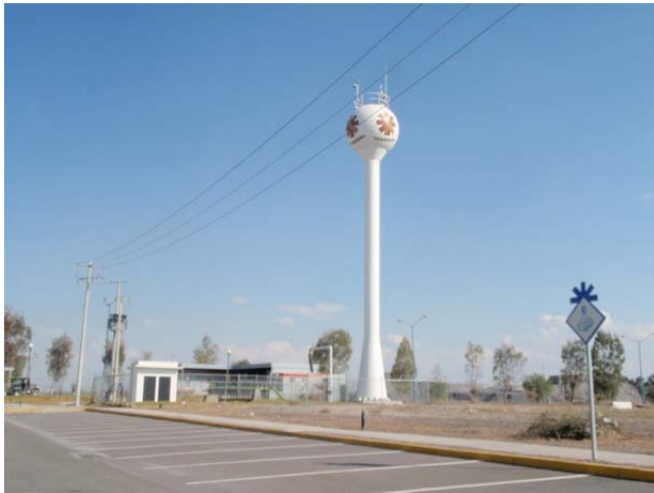
POZO DE EXTRACCION
