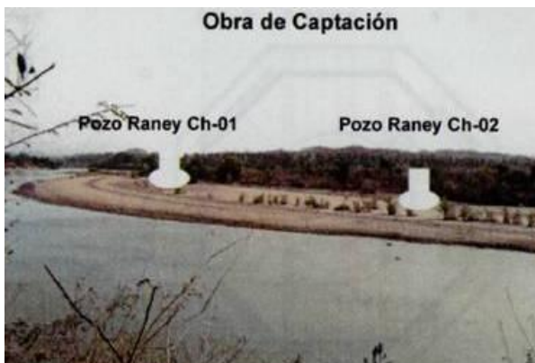
Imagen 15. Pozos radiales de 625 l.p.s.
