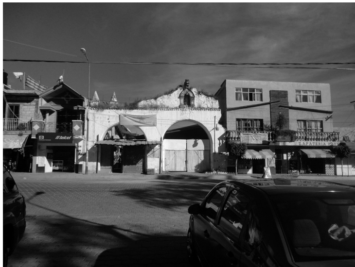
Totimehuacan. 2010. En esta foto se aprecia la misma arcada real, rodeada por construcciones recientes de hasta tres niveles con lonas y colgijos amarrados a la construcción patrimonial del s.XVI. Esta imagen ilustra como el atrio fué lotificado y la valoración del patrimonio por parte del pueblo es prácticamente nula.
