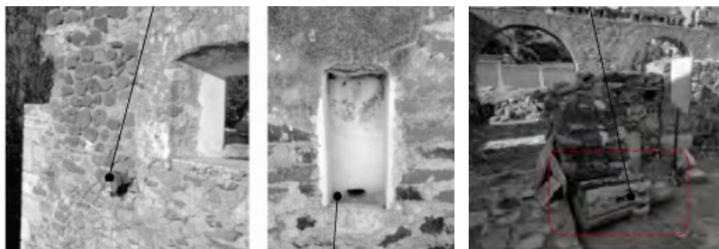
Gárgolas, captadores de agua en placeres y bajantes pluviales en contrafuertes.
