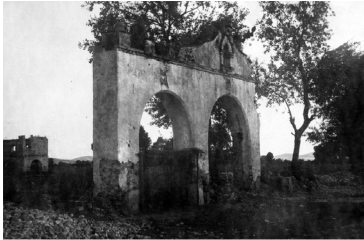
Totimehuacan. 1958. Fotografía tomada desde la plaza hacia la Alameda real del atrio franciscano. La arcada se encuentra parcialmente demolida por la acción de los sismos
