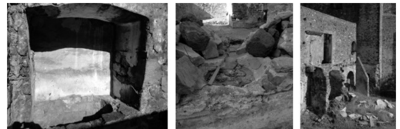
Tina o lavabo en los placeres, en planta alta. Hornilla en intradós de muro en cocina. En la foto de la derecha se ilustra la ruina del un muro digonal que no sabemos a qué deba su forma.
