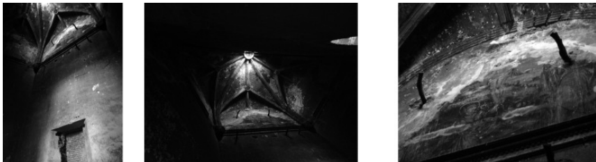
Semi bóveda nervada en presbiterio de nave, con restos de pintura mural.
