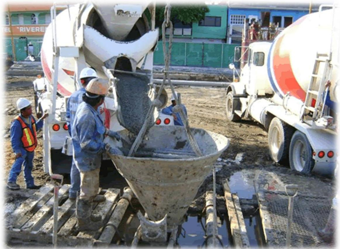
**3.1.6 Colocación de concreto en muro Milán**
