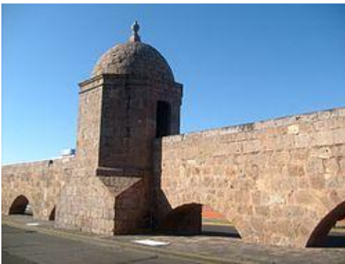
Esta es la parte del acueducto que aparece en el billete de 50 pesos.
