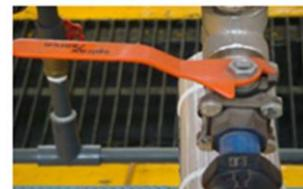
Fig. 23.- Válvula de bola
