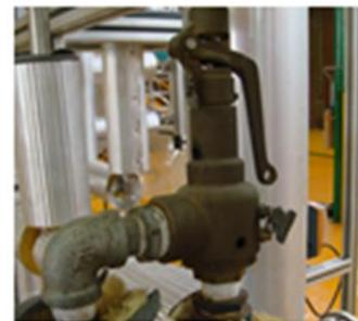
Fig. 27.- Válvula de seguridad para vapor
