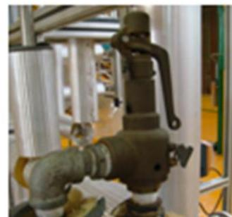
Fig. 50.- Válvula de seguridad para vapor
