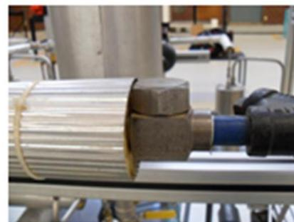
Fig. 28.- Trampa termodinámica
