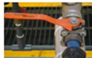
Fig. 46.- Válvula de bola
