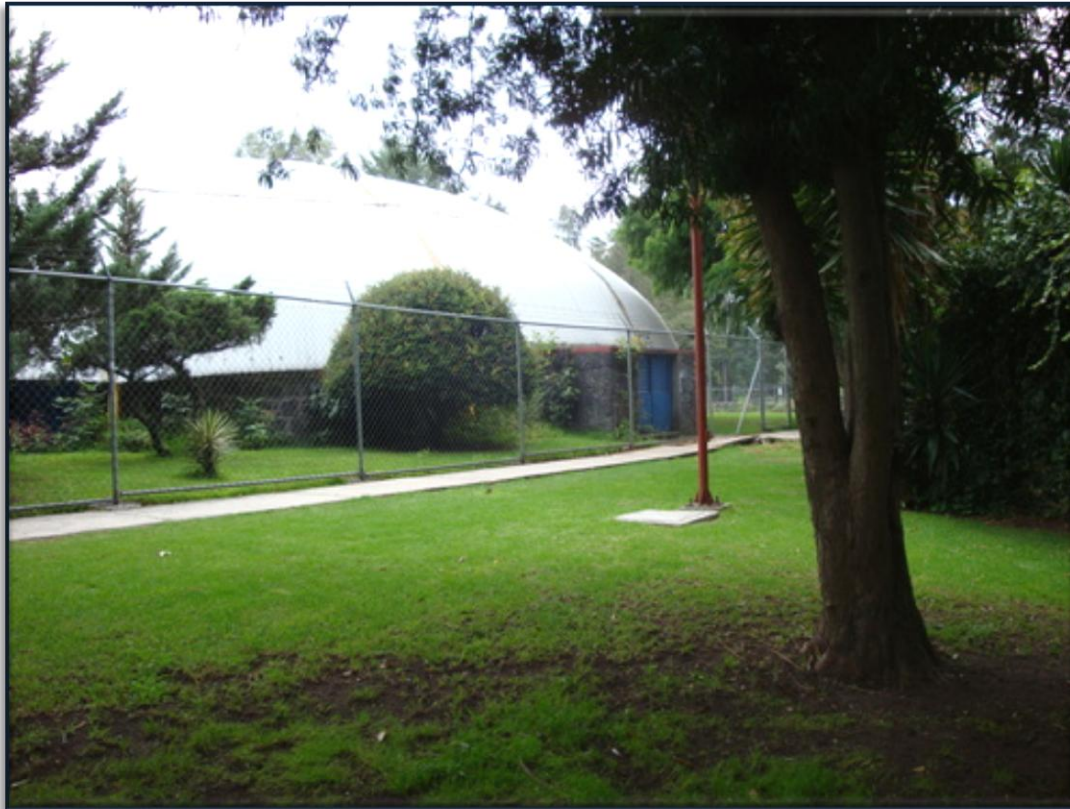
FACHADA POSTERIOR INVERNADERO
