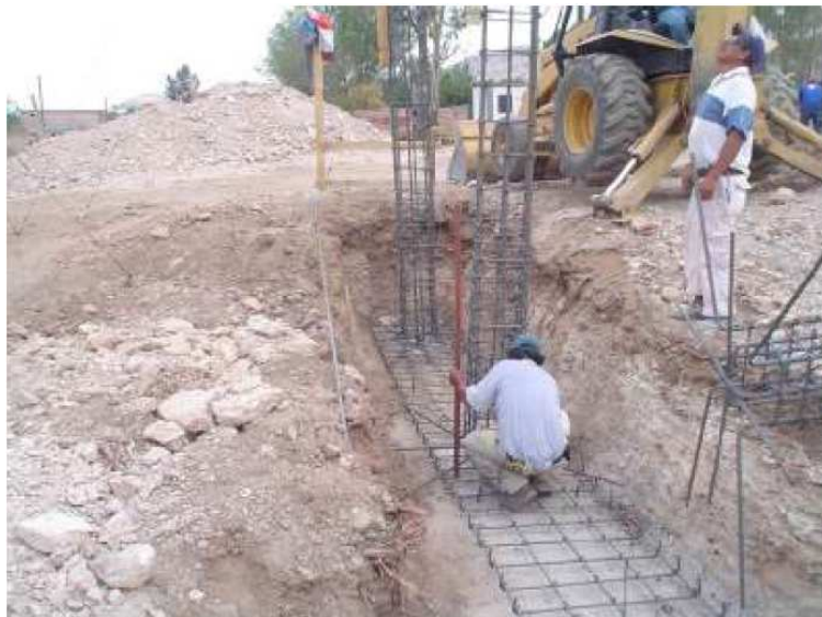
COLOCACIÓN DEL ACERO EN UNA ZAPATA CORRIDA
