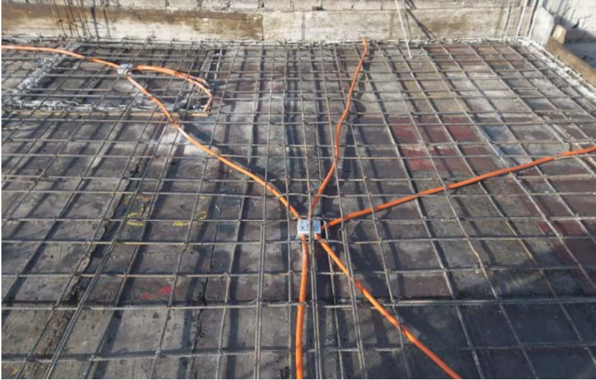
INSTALACIÓN DEL TUBO CONDUIT FLEXIBLE (PARED LISA)
