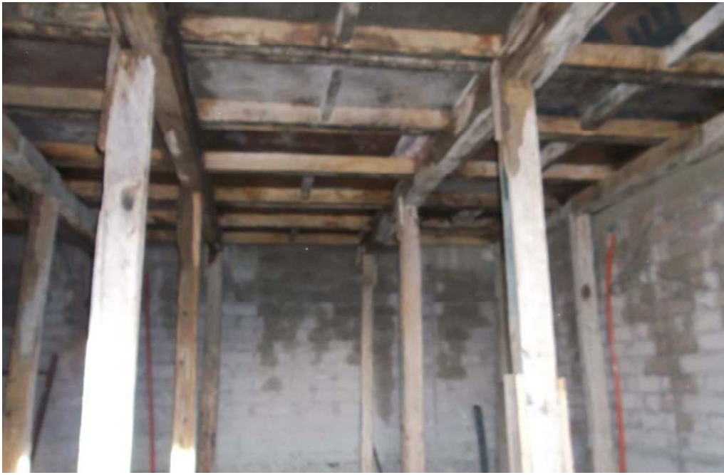
CIMBRA DE MADERA
