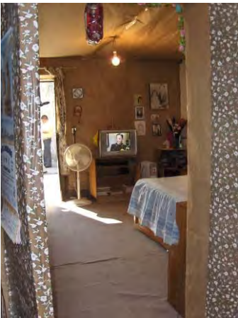
Figura 43: Vecindad en el n°71 de la calle Guatemala: Muros y plafones son recubiertos de papel para disimular y "prevenir" el desprendimiento de elementos de albañilería. La instalación sanitaria igual que la eléctrica es improvisada y obsoleta y contribuye a acelerar el deterioro del edificio. La instalación de gas es inexistente por lo que tanques de gas son visibles en viviendas y patios.
