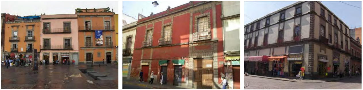
Figura 30: Edificios del siglo XVIII : calle Seminario , calle Correo Mayor y esquina de las calles Correo Mayo y Soledad.
