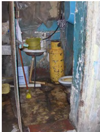
Figura 43: Vecindad en el n°71 de la calle Guatemala: Muros y plafones son recubiertos de papel para disimular y "prevenir" el desprendimiento de elementos de albañilería. La instalación sanitaria igual que la eléctrica es improvisada y obsoleta y contribuye a acelerar el deterioro del edificio. La instalación de gas es inexistente por lo que tanques de gas son visibles en viviendas y patios.
