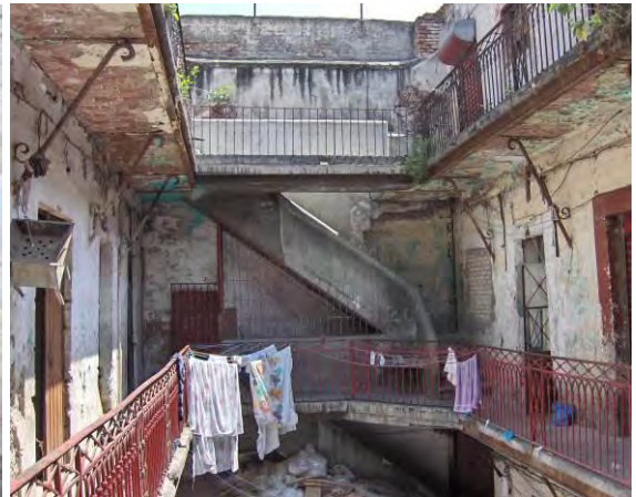
Figura 43: Vecindad en el n°71 de la calle Guatemala: Muros y plafones son recubiertos de papel para disimular y "prevenir" el desprendimiento de elementos de albañilería. La instalación sanitaria igual que la eléctrica es improvisada y obsoleta y contribuye a acelerar el deterioro del edificio. La instalación de gas es inexistente por lo que tanques de gas son visibles en viviendas y patios.
