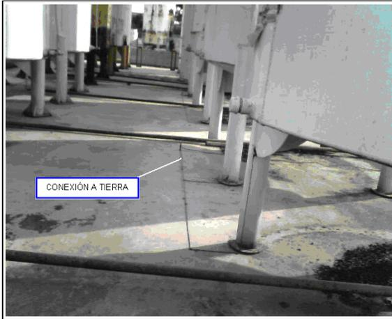
Figura 4.16. Tanques de almacenamiento conectados a tierra.
