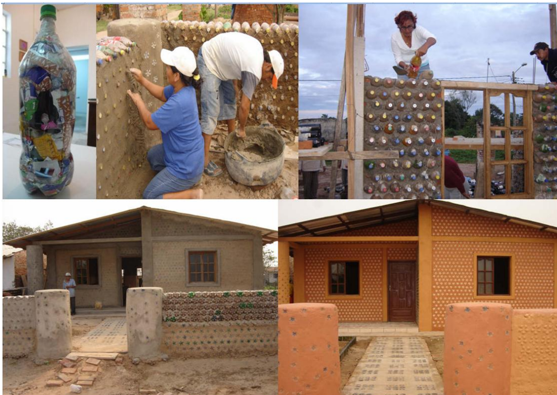
Figura 2.9 Utilización de envases de PET como tabiques.
