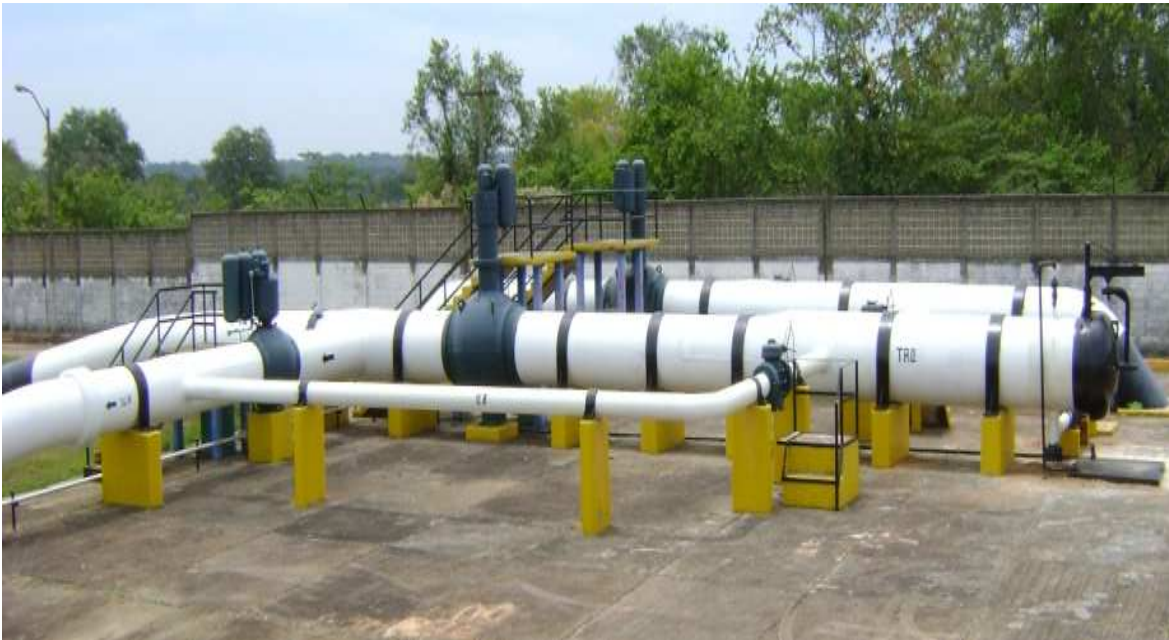
Figura 3.1 Trampa receptora de diablos.
