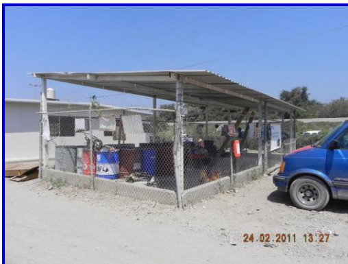
Figura 48. ATRP con cárcamo canaleta perimetral y con acceso restringido
