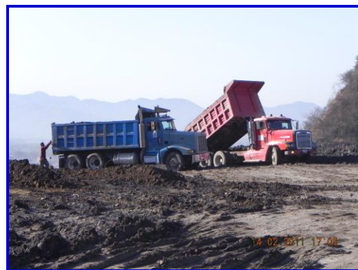
Figura 32. Material de rezaga depositado en el banco de tiro
