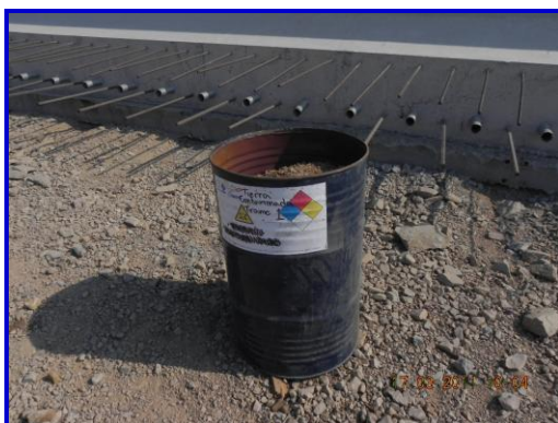
Figura 46. Colocación del suelo contaminado en contenedores debidamente rotulados
