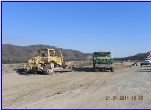
Figura 31. Conformación de caminos con material producto de los cortes
