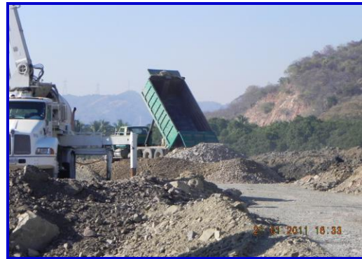
Figura 31. Conformación de caminos con material producto de los cortes
