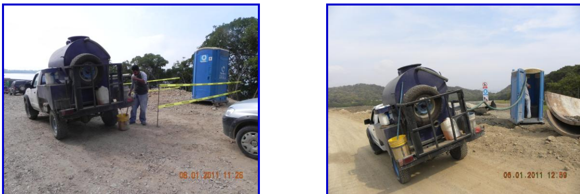
Figura 38. Mantenimiento de casetas sanitaria
