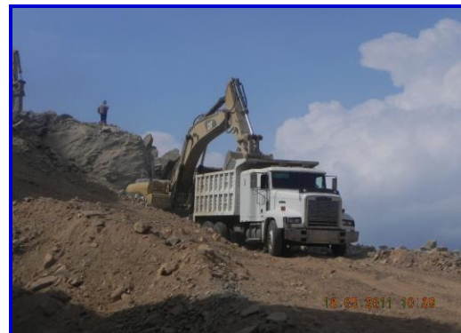
Figura 30. Acarreo de material para conformar los caminos de acceso y hacia el banco de tiro
