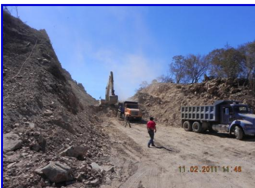
Figura 30. Acarreo de material para conformar los caminos de acceso y hacia el banco de tiro
