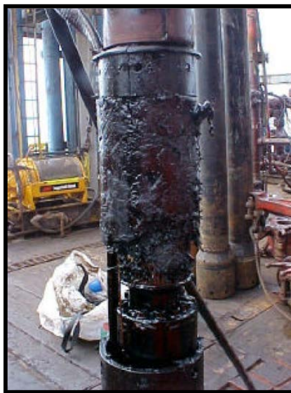
Figura 4.3. Taponamiento de la Entrada de la Bomba.
